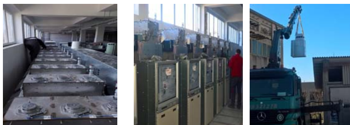
Slika 3 - Montaža novog postrojenja
