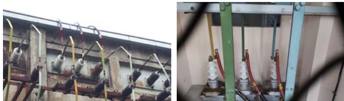
Slika 2 - Pripremni elektromontažni radovi
